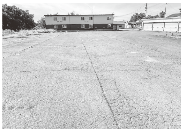
定住促進住宅裏に広がる旧峰浜庁舎跡地
